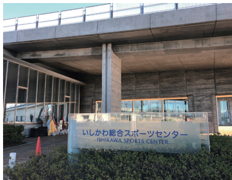
▶15次避難所のスポーツセンター
